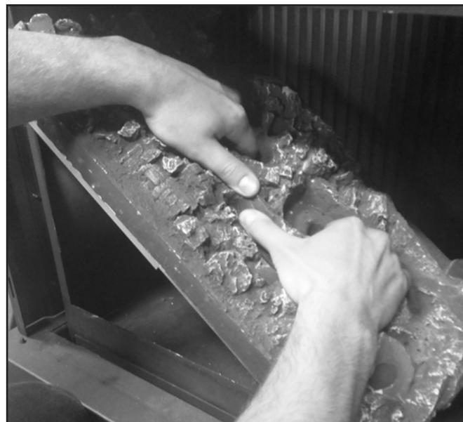
Figure 26. Brûleur Dépose - Faire tourner de 45 degrés
